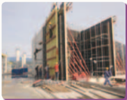
Construction site of the Grand Ice Arena in Sochi. Строительная площадка Центра ледового спорта в Сочи
